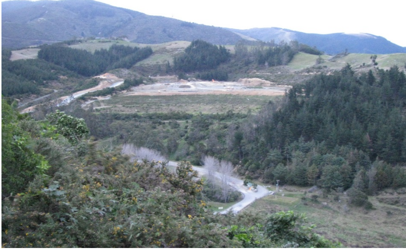
York Valley Landfill
